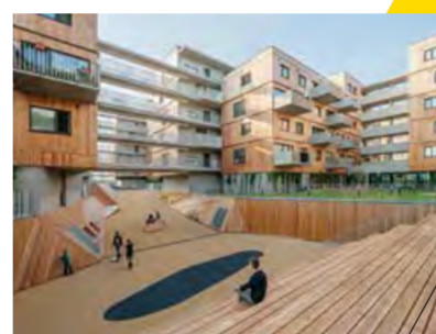
Holzwohnbau Seestadt Aspern, Arch. Berger+ Parkkinen / querkraft, 2015, © hertha hurnaus | berger+parkkinen | querkraft
